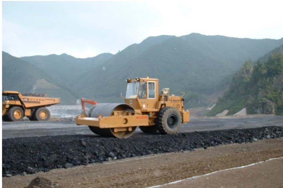
加速度応答による締固め管理
