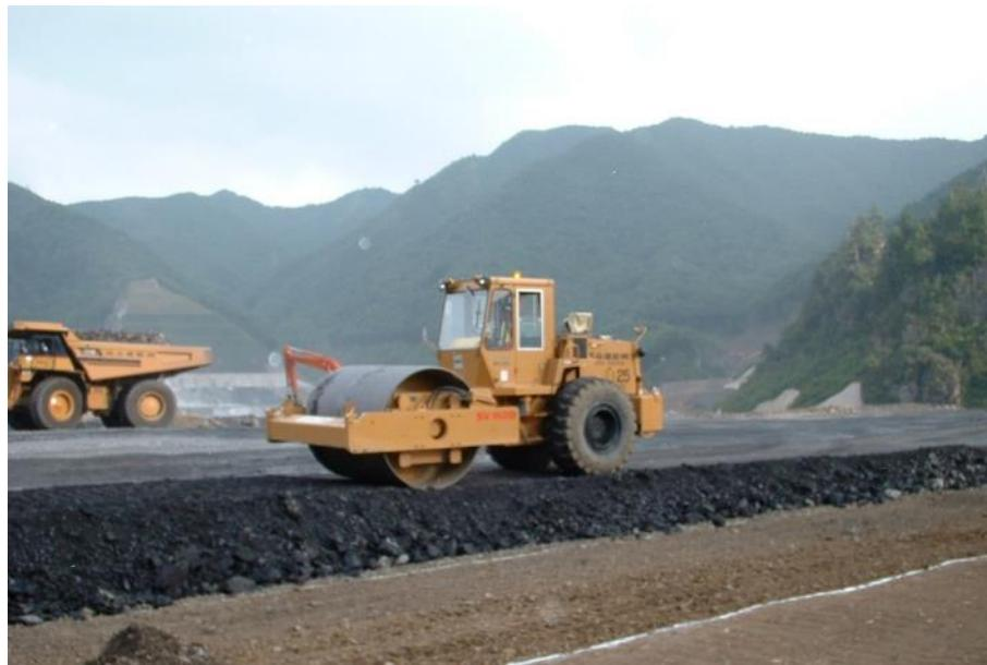
加速度応答による締固め管理
